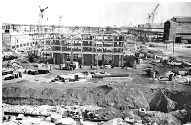
Строится Центральная заводская лаборатория
