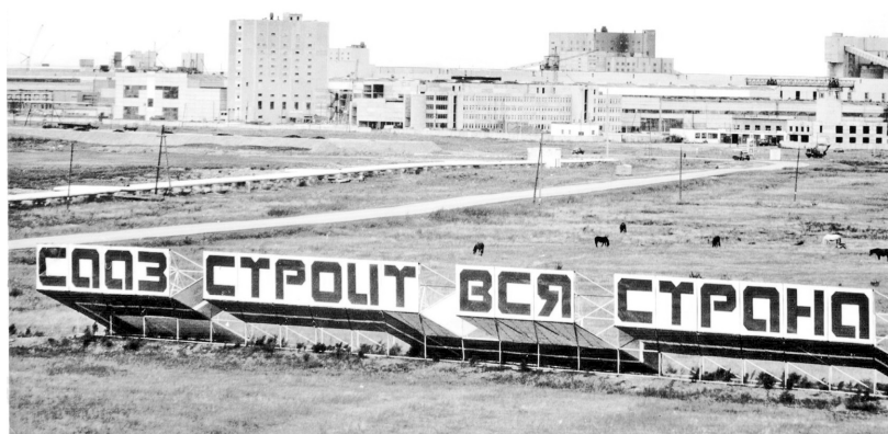
Панорама промплощадки уплотняется
