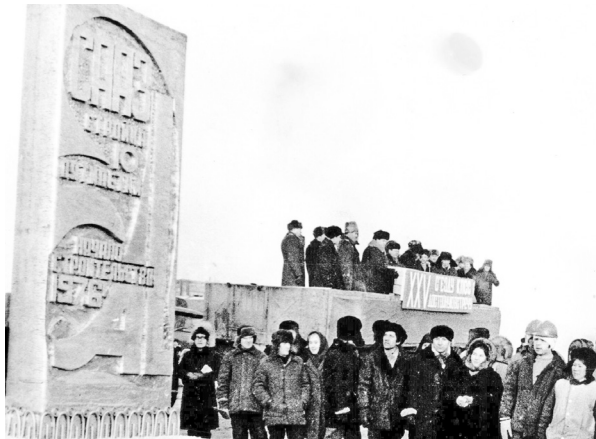
Открытие стройки СаАЗа (19 января 1976 г.)
