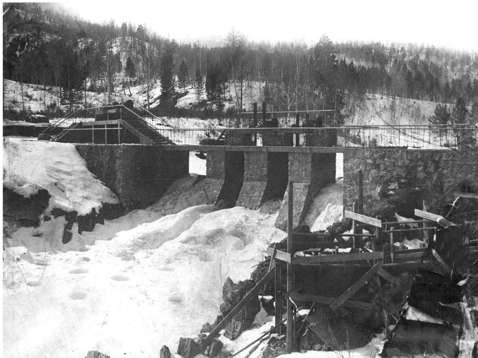
Головное гидротехническое сооружение. Плотина из бутового камня (1939 год)
