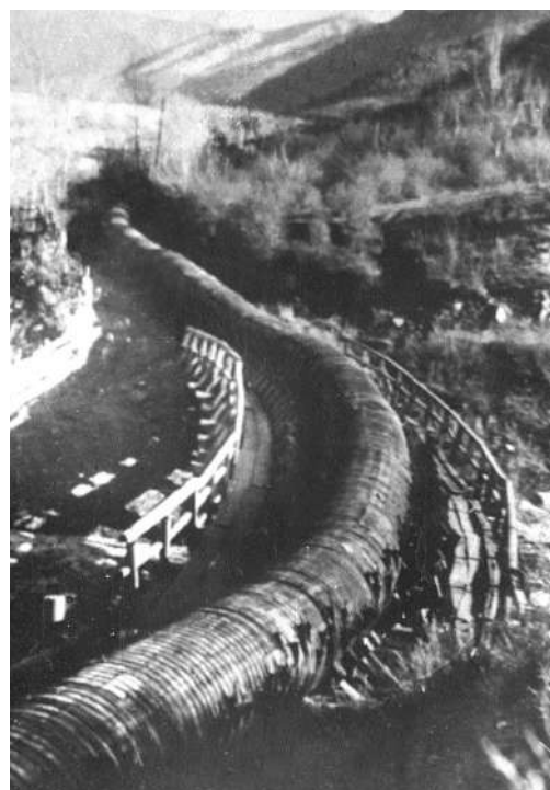
Общий вид трубопровода (сборный из клёпок) длиной 6 км, диаметром 125 см
