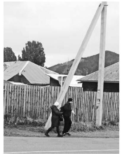
Пешеходный тротуар упирается в опору
