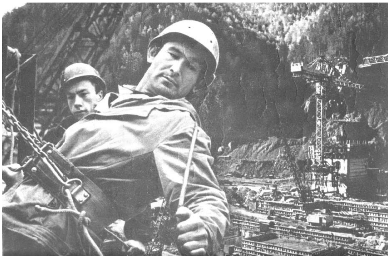
Урал Рузыкулов закрепился на монтажном поясе
