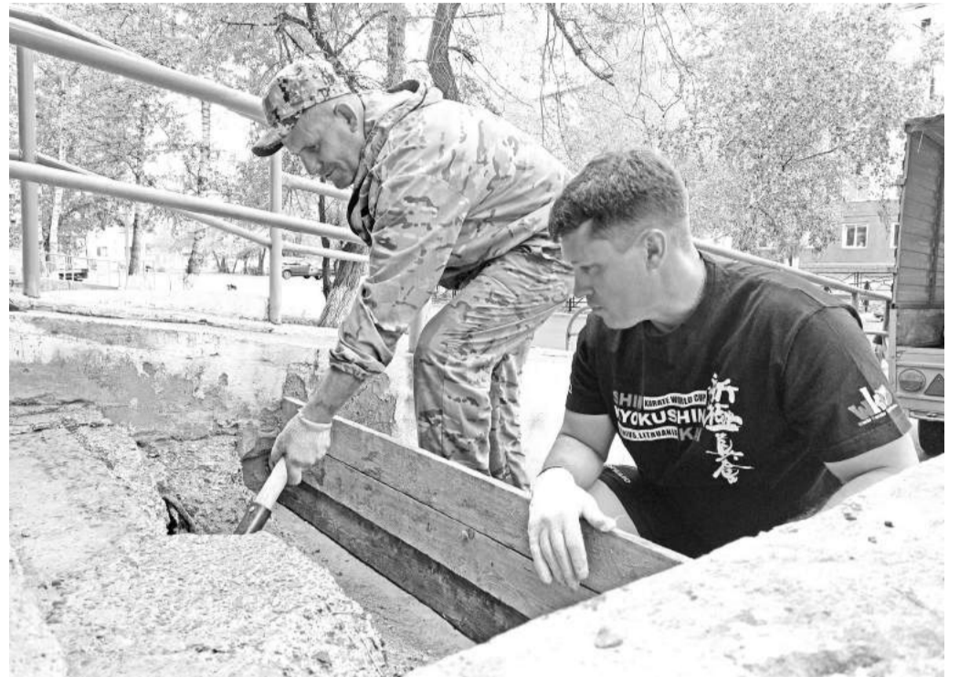
Кандидаты от «Единой России» работы не боятся. Евгений Молодняков и Александр Пащенко ремонтируют ступеньку у входа в «Красный Крест»
