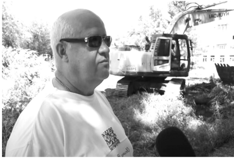
Подрядчик следит за ходом работ
