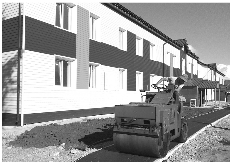
Последний штрих - бетонная дорожка
