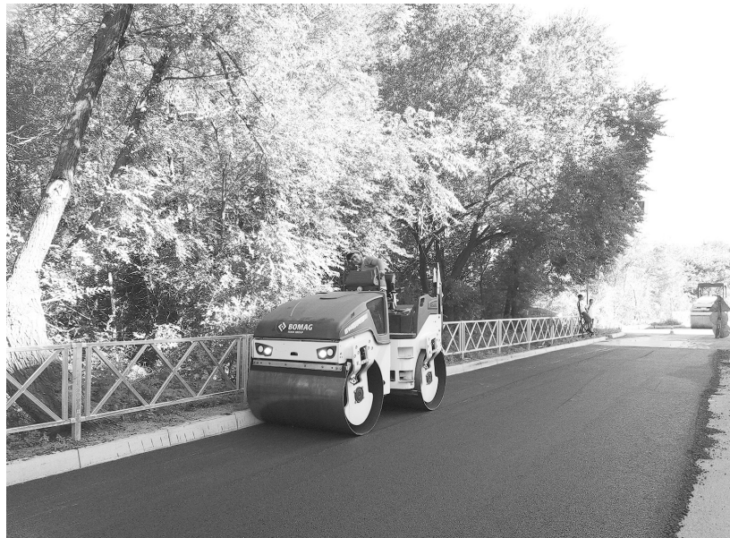
Идёт ремонт по улице Ярыгина
