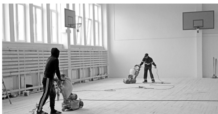
Ремонт спортзала в разгаре
