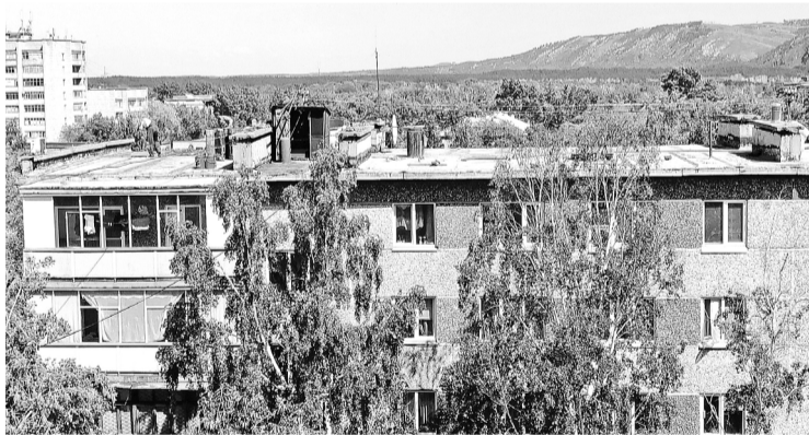
Дом ждёт капремонта
