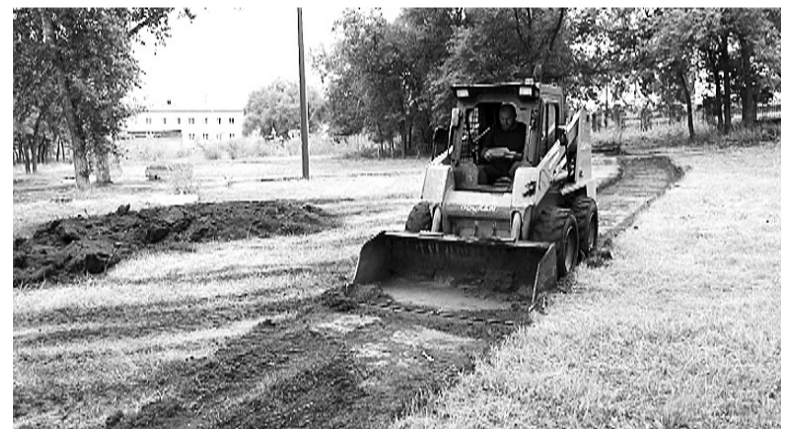
Устройство пешеходных дорожек в Парке Победы
