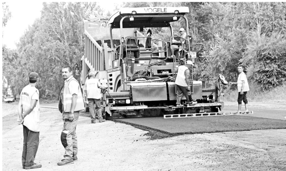
Здесь взрослые заботы - дорожные работы
