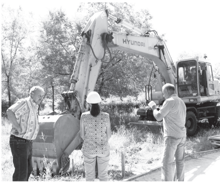
Экскаватор «вгрызается» в сухой грунт
