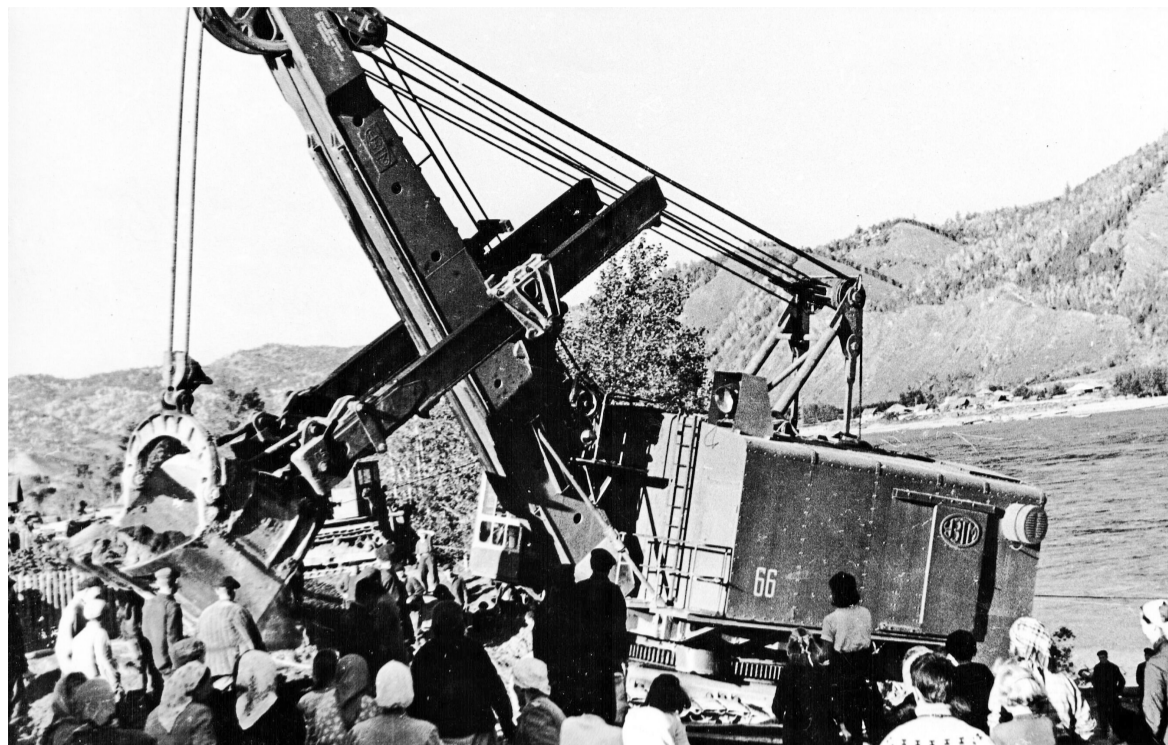
12 сентября 1963 года прибыл из Дивногорска со строительства Красноярской ГЭС первый экскаватор ЭКГ-4,6
