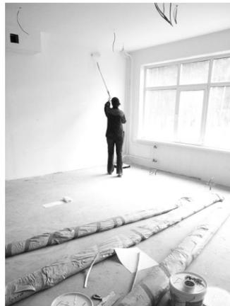
К капитальному ремонту образовательного учреждения строители приступили год назад. За это время отремонтированы основные конструкции и выполнена перепланировка стен, установлены новые системы отопления и водоснабжения, заменены электросети и пожарная сигнализация, произведен ремонт вентиляции, перекрыта кровля и утеплены межпанельные швы.
