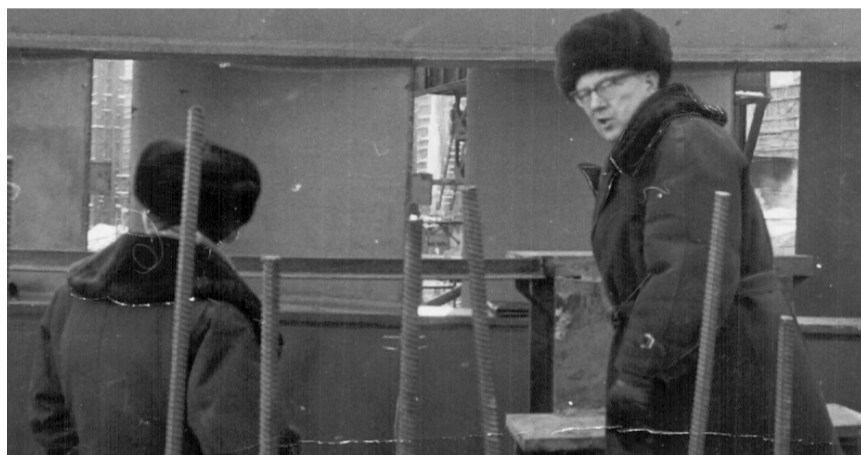
Н.В. Затовский на монтажной площадке
