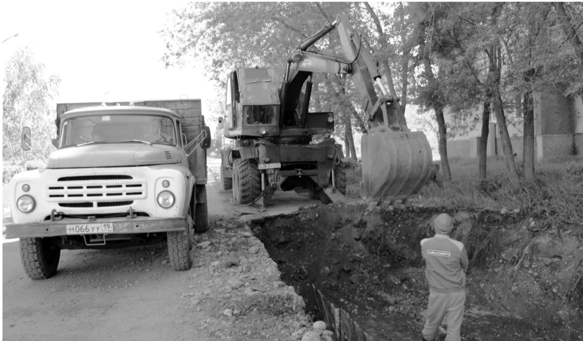
Байкалэнерго ведет ремонт сетей у дома №41 Ленинградского мкр.
