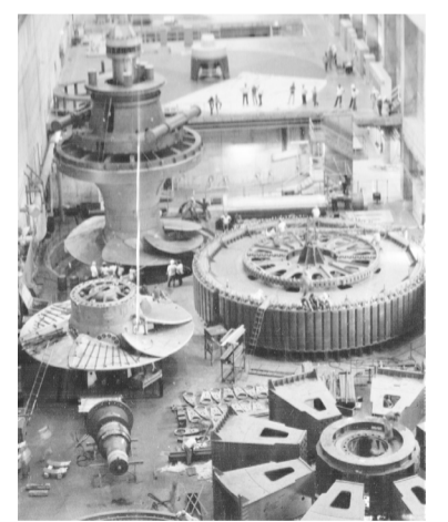
Идет сборка узлов гидроагрегатов
