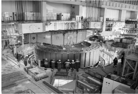
На этом гидроагрегате завершаются монтажные работы. В его кратере закончилась сборка основных узлов: на штатные места установлены рабочее колесо с валом, статор генератора и самый массивный узел агрегата - ротор весом 900 тонн.
