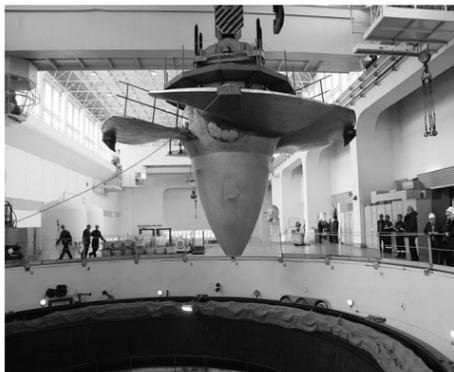
В кратер гидроагрегата установлено рабочее колесо турбины. В машинном зале станции началась сборка основных узлов гидроагрегата, который в ноябре 2012 года был выведен из работы для проведения комплексной реконструкции.
