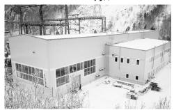
В ходе испытаний оборудование успешно прошло проверку на соответствие классу напряжения и изоляционным свойствам под напряжением 560 кВ. Кроме этого, завершены основные строительные работы по зданиям нового распределительного устройства и щитовых устройств, монтаж систем вентиляции и пожаротушения. Комплектное элегазовое распределительное устройство предназначено для передачи энергии, которую вырабатывает Саяно-Шушенская ГЭС в единую энергосистему Сибири.
