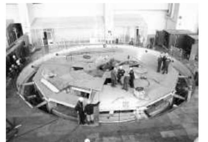
До ввода этого гидроагрегата в эксплуатацию остались считанные дни, поэтому все силы сосредоточены на подготовке гидросилового оборудования к пуску на холостой ход. Согласно графику ведутся пуско-наладочные работы системы автоматического управления гидроагрегатом, монтируются вспомогательное оборудование и система пожаротушения.
