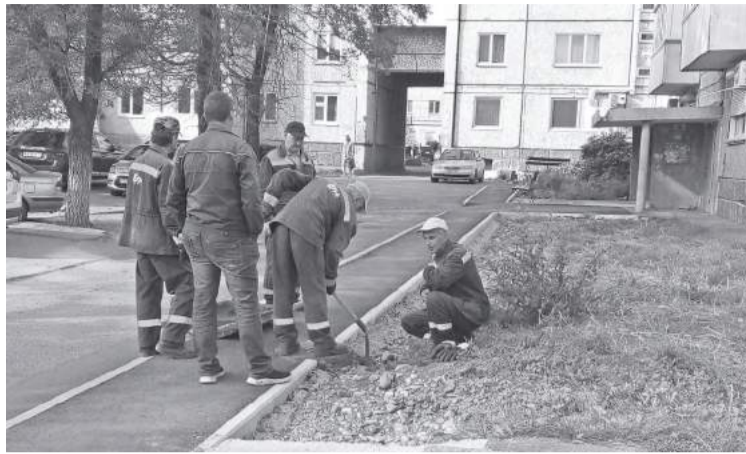
Есть бетонная «заплатка»!
