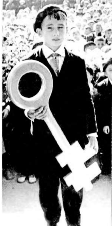
1 сентября 1967 года - Саша Кижнер получил от строителей ключ от новой школы
