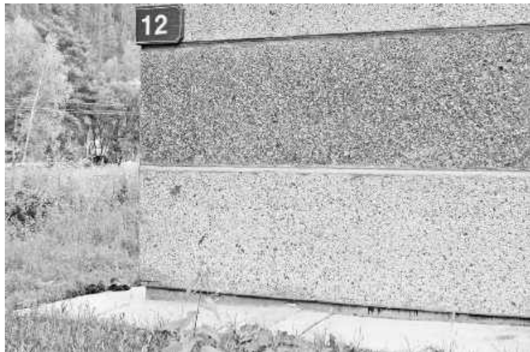
На доме № 12 в 2015 году были отремонтированы отмостки
