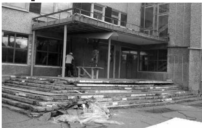
Ведутся работы на крыльце Центра детского творчества
