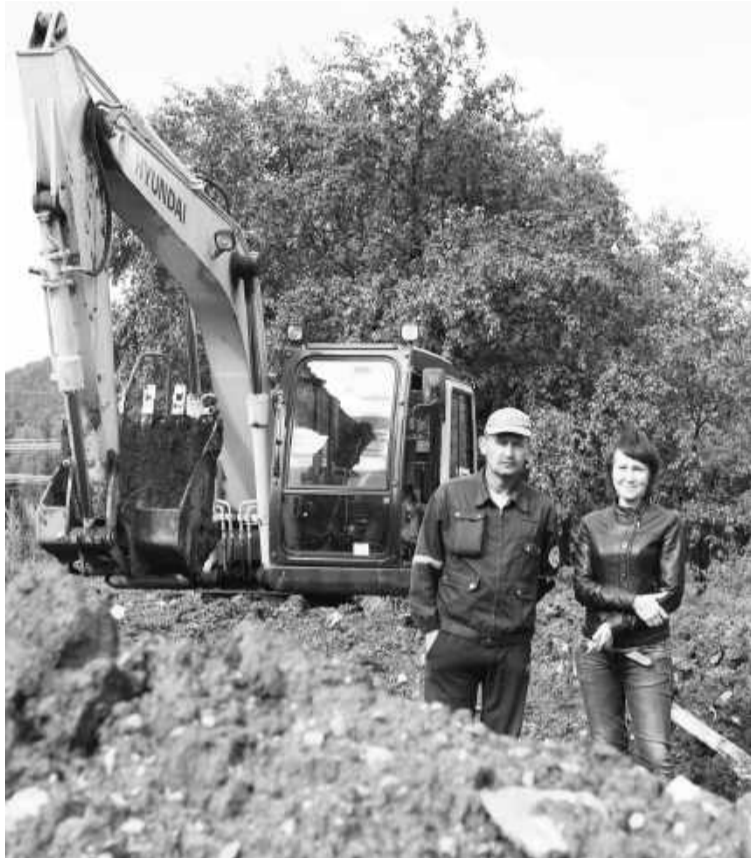
Юлия Коновалова: «Гидравлическое испытание будущего водопровода прошло успешно»
