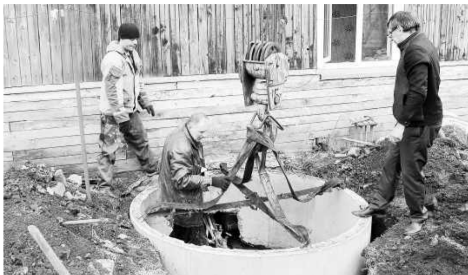
Идет монтаж узла учета и управления
