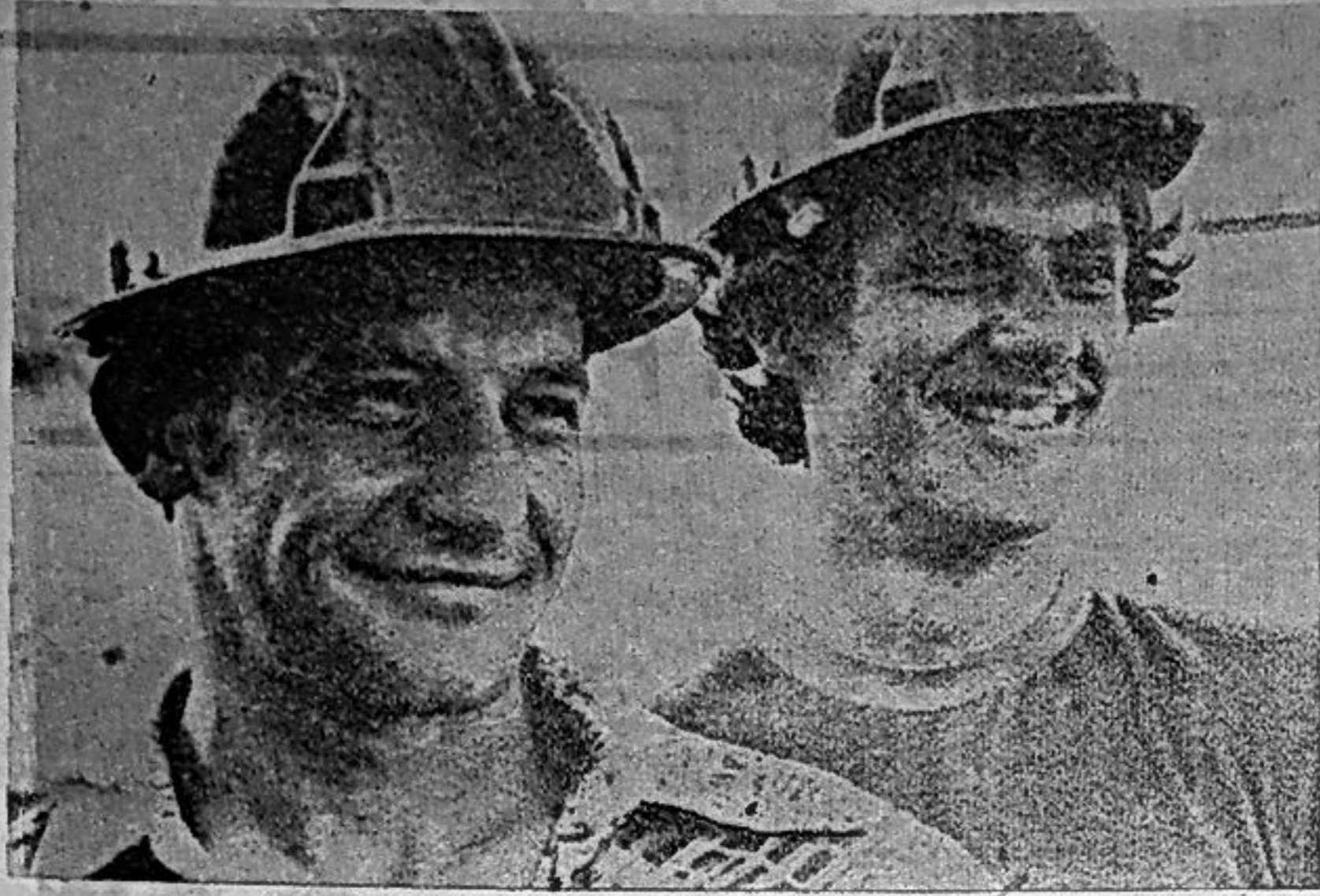
Молодые рабочие, которых вы видите на снимке, — Николай Косьянов (звеньевой) и Александр Мельников из бригады плотников-бетонщиков В. И. Диденко из СУ-37. Бригада Диденко работает на строительстве комбината сборно-разборных зданий министерства геологии.
