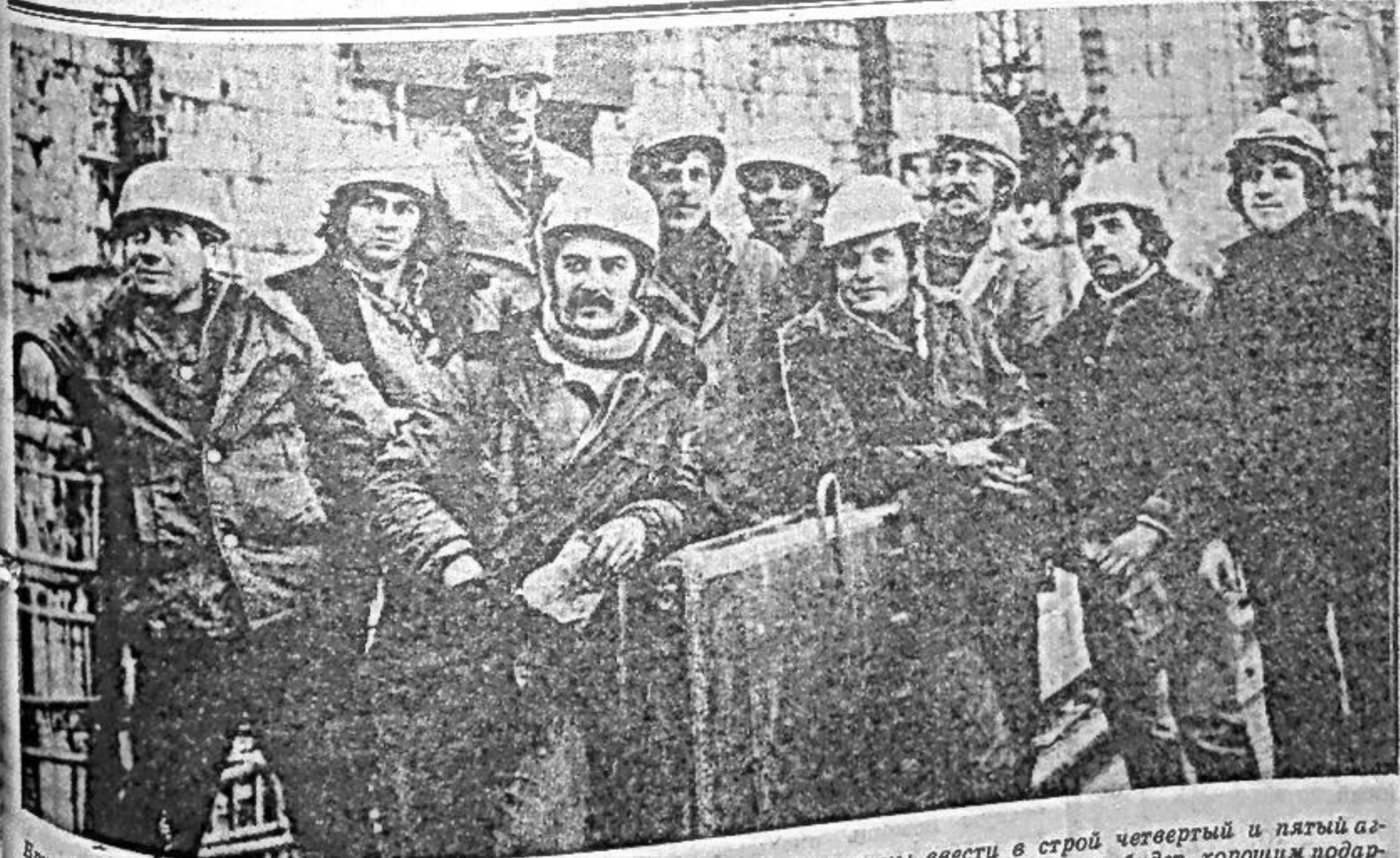
Бригада плотников-бетонщиков лауреата премии Ленинского комсомола С. Коленкова трудится на возведении плотины Саяно-Шушенской ГЭС. Гидростроители намерены ввести в строй четвертый и пятый агрегаты в нынешнем году, что будет хорошим подарком XXVI съезду партии.
