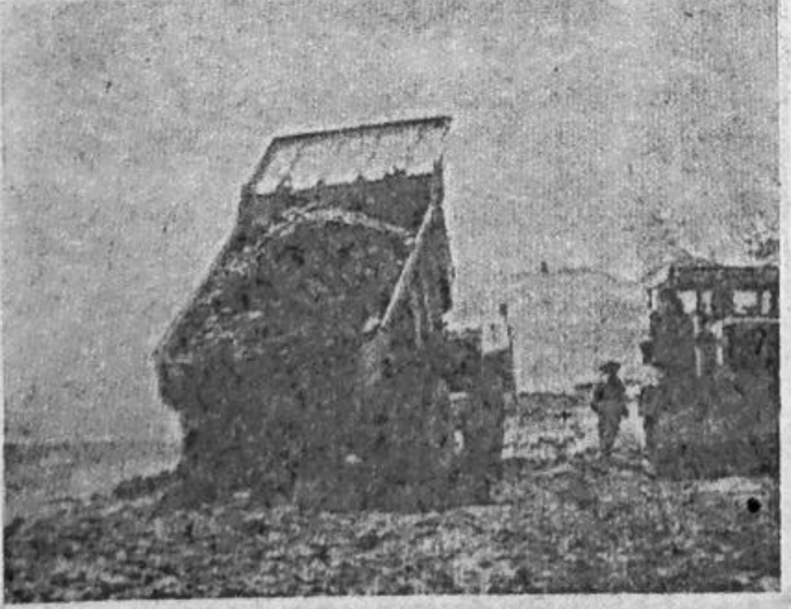
На снимках: Г. Г. Пупков в день укладки первого кубометра бетона; в створе Майнской ГЭС. Фото Ю. УРАЛЬСКОГО.
