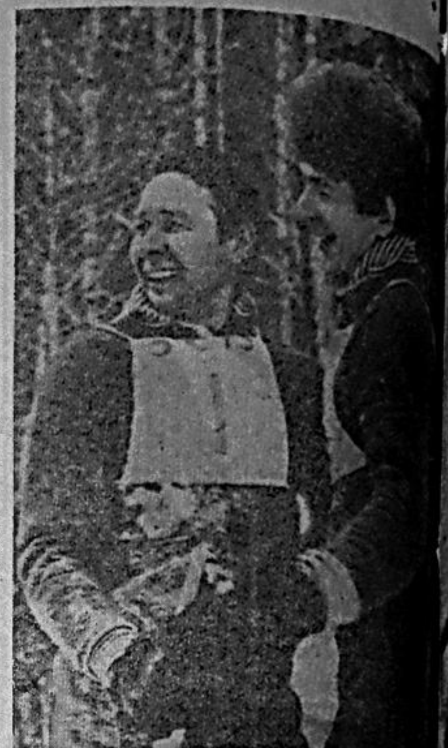
Бригада плотников-бетонщиков имени Ю. А. Рина, возглавляемая Героем Социалистического труда В. А. Позняковым и ленинградская бригада сарей-сборщиков Героя Социалистического труда В. С. Чичерова с Металлического завода перенесли перекрытия Енисея в 1975 году, заключив договор о соревновании — открыли новую, рабочую дружбу по созданию Саяно-Шушенской ГЭС. Друзья вновь встретились в Саянах. На этот раз в выходной день соревновались в лыжных гонках. Победила дружба. Впереди новые трудовые будни.
