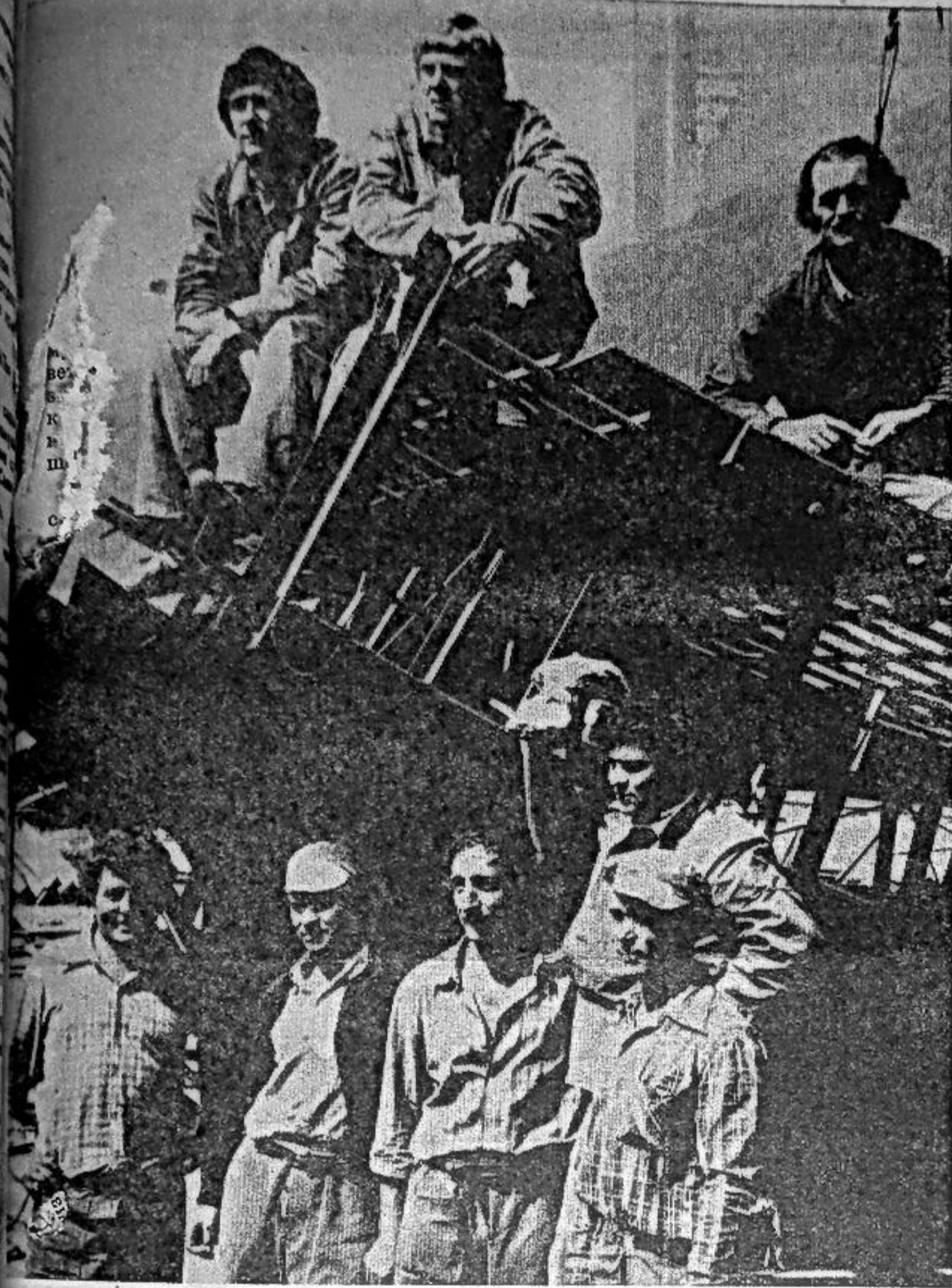
Бригада монтажников арматурного цеха, возглавляемая Анатолием Ивановичем Антипиным, изготавливает облицовку шахт гидроагрегатов. Сейчас закончена пятая шахта. На снимке: монтажники у облицовочной шахты В. И. Удалов, Н. П. Ковригин, бригадир А. И. Антипин, Ю. Ф. Бугаков, В. Я. Юминов, С. Е. Фалеев, В. А. Андреев, Н. М. Елесеев. Фото А. РУДНИЦКОГО.
