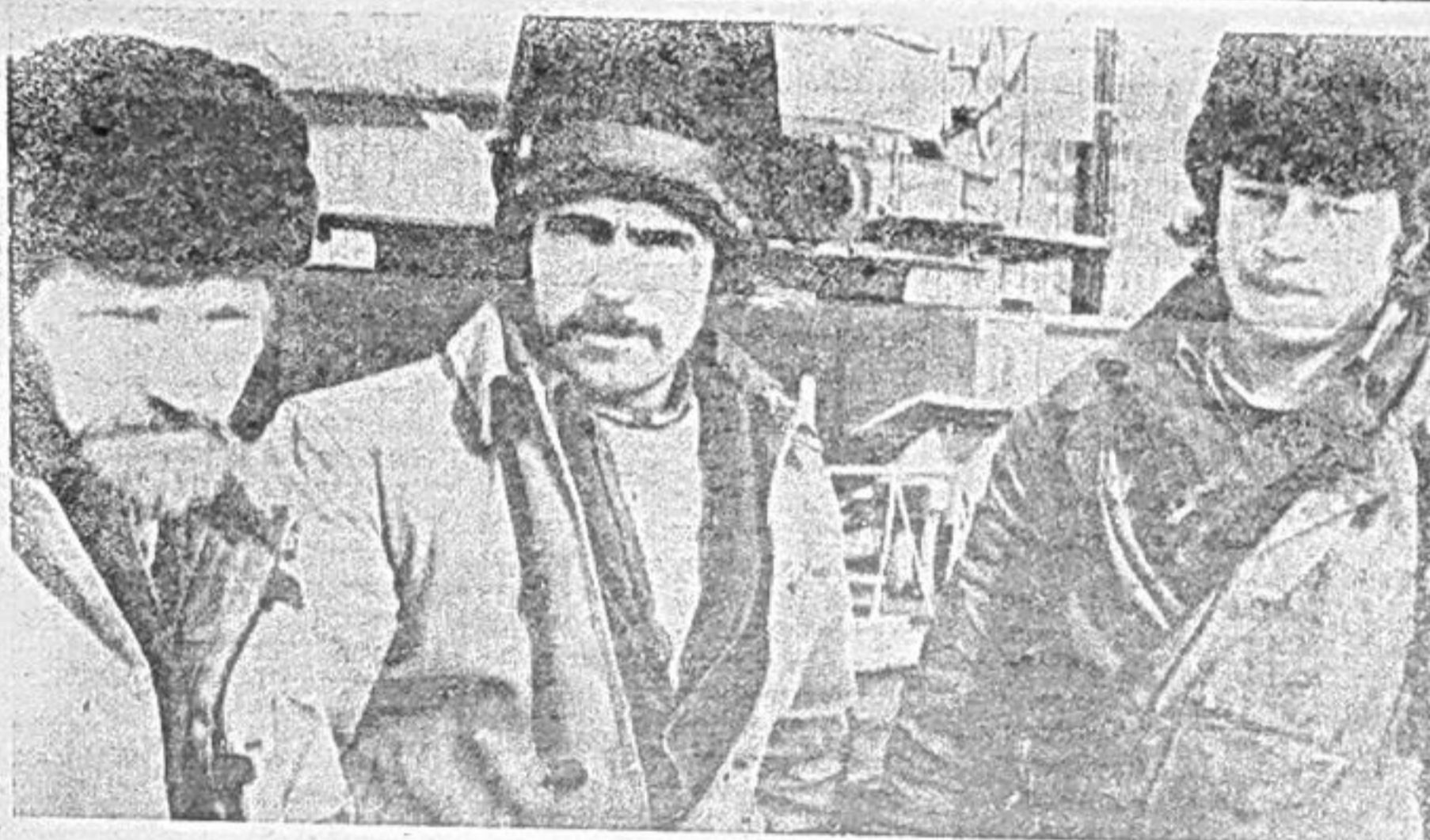
Бригада монтажников Николая Таскина работает на строительстве Майнской ГЭС. Проведение трасс для пара, воды и сжатого воздуха, оборудование насосного хозяйства — все это заботы коллектива. Сейчас, когда на новой ГЭС пошел бетон, работ прибавилось. На снимке: передовики производства Ю. Ф. Полосин, Г. В. Леонтьев, А. И. Ренжин. Фото А. РУДНИЦКОГО.
