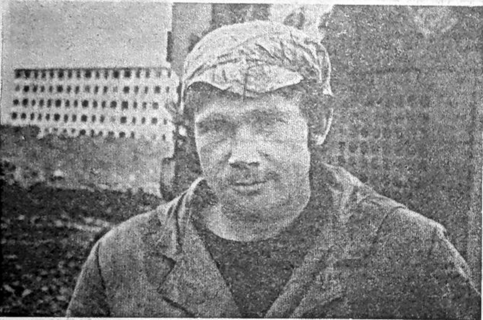
Мощный рокот бульдозера разносится рядом с новыми микрорайонами городка СаАЗа. Это Анатолий Николаевич, бульдозерист из УМ-12, подготавливает площадку для подкрановых путей.
