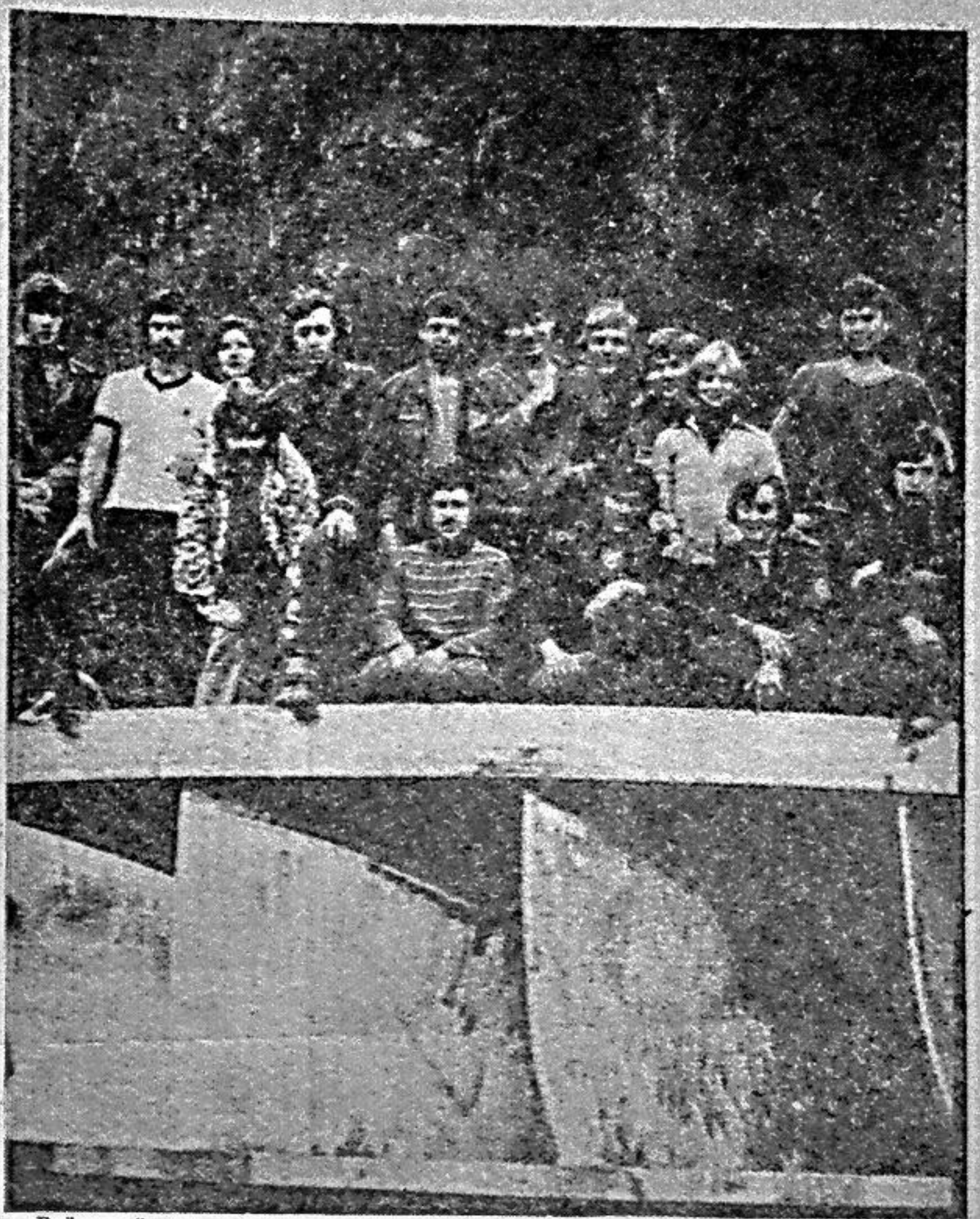
Районный студенческий строительный отряд «Ленинград» встречает четвертое рабочее колесо — подарок с берегов Невы гидростроителям Саяно-Шушенской ГЭС.
