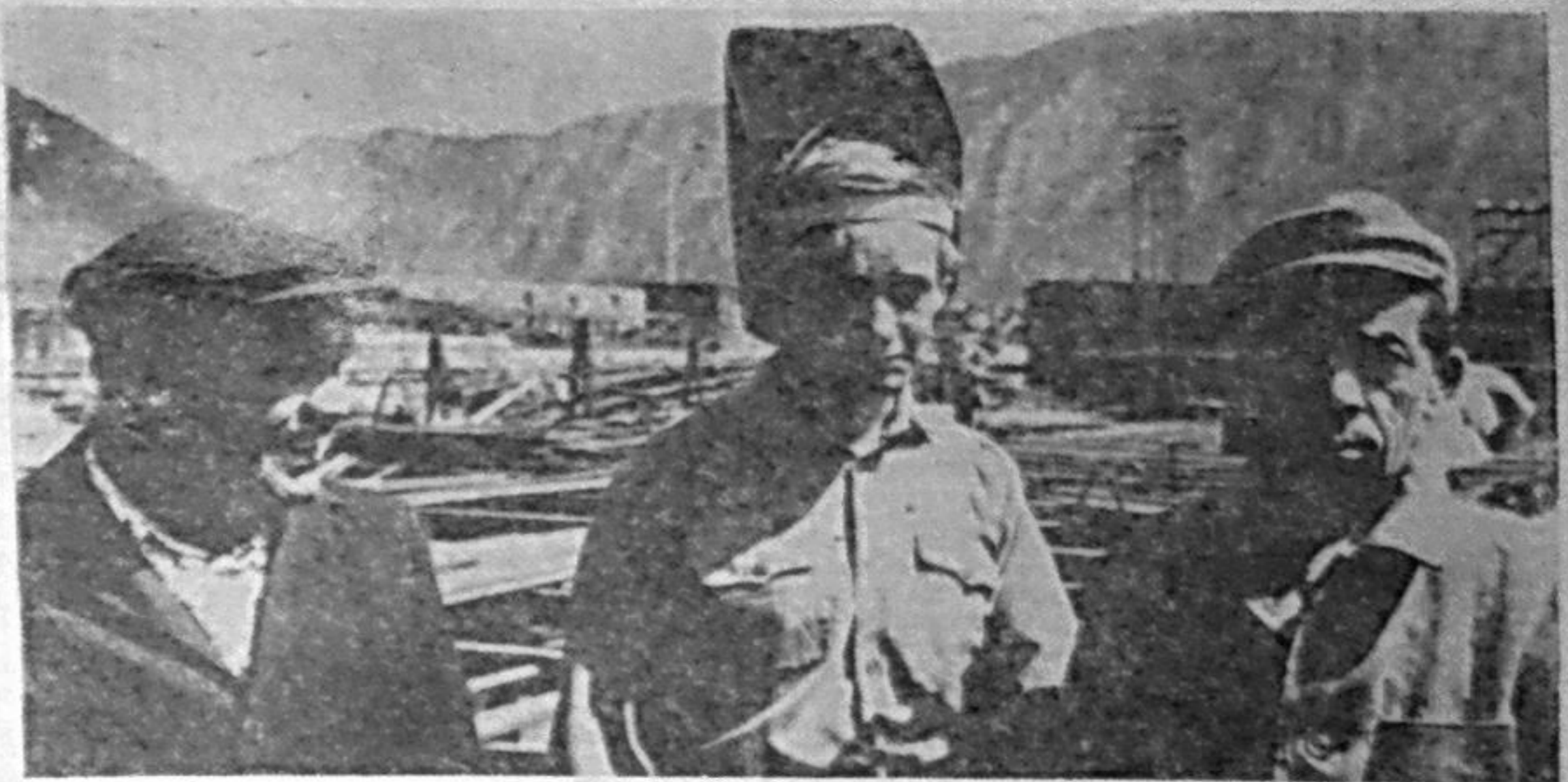
В известной бригаде А. И. Воронова арматурного участка работают высококвалифицированные электросварщики Алексей Керг, Николай Некрасов и Мовлят Гимаев. Эти люди проработали в Красноярскгэстрое около двадцати и более лет. Только за пол-
