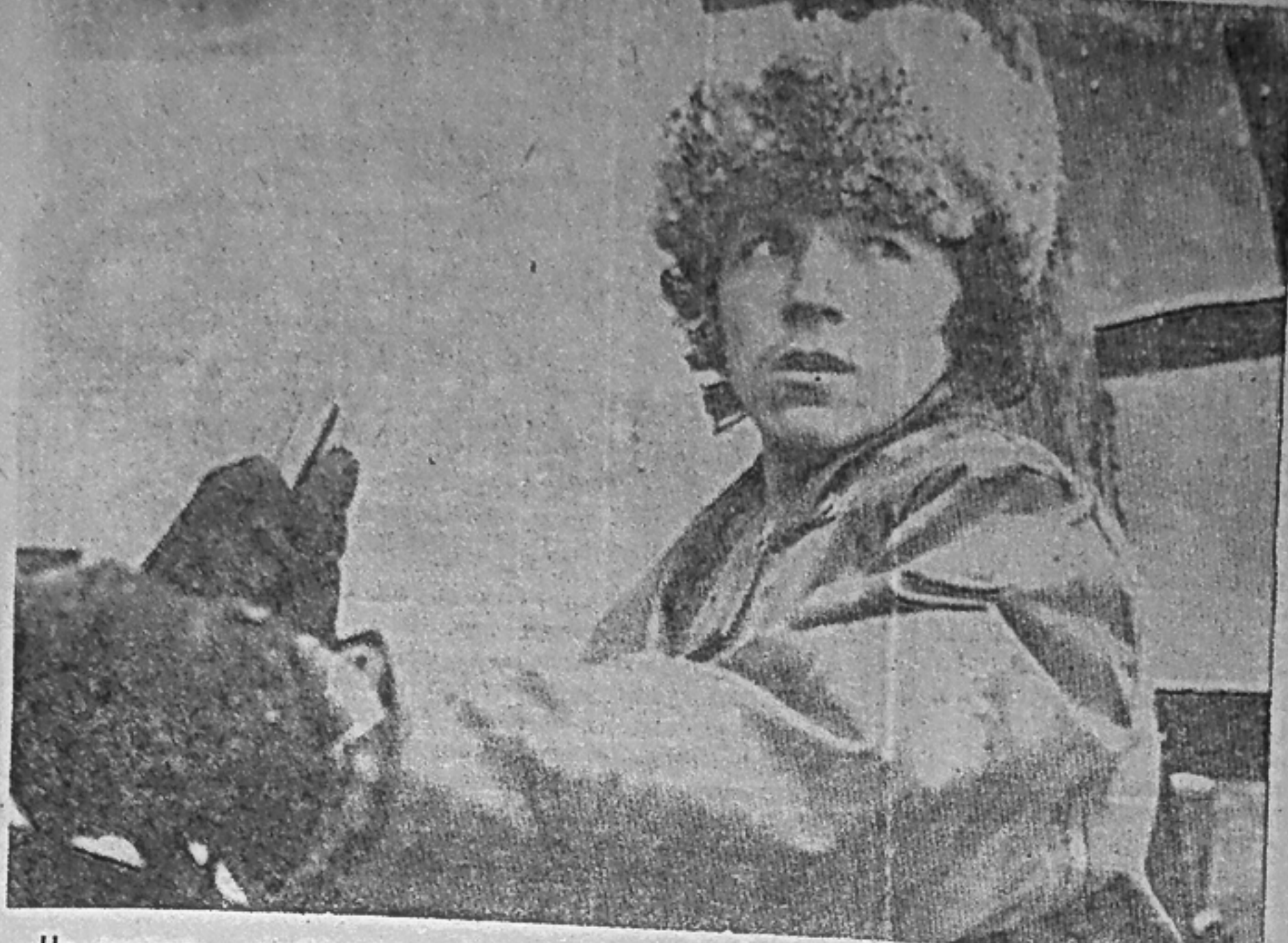
На снимке: комсомолец, бурильщик экспедиции № 7 Виктор Фролов. Он участвует в выполнении ответственных работ на станционной части плотины.
