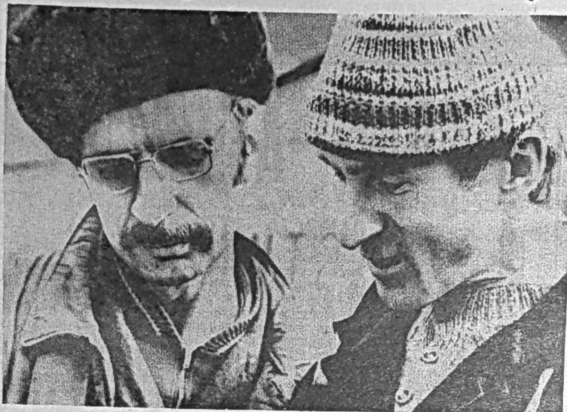
Ленинградцы и саяногорцы работают в тесном контакте на пусковых объектах гидроэлектростанции. На снимке: бригадир обмотчиков Ю. П. Сторожов и старший мастер В. А. Плотянский (объединение «Электросила»).
