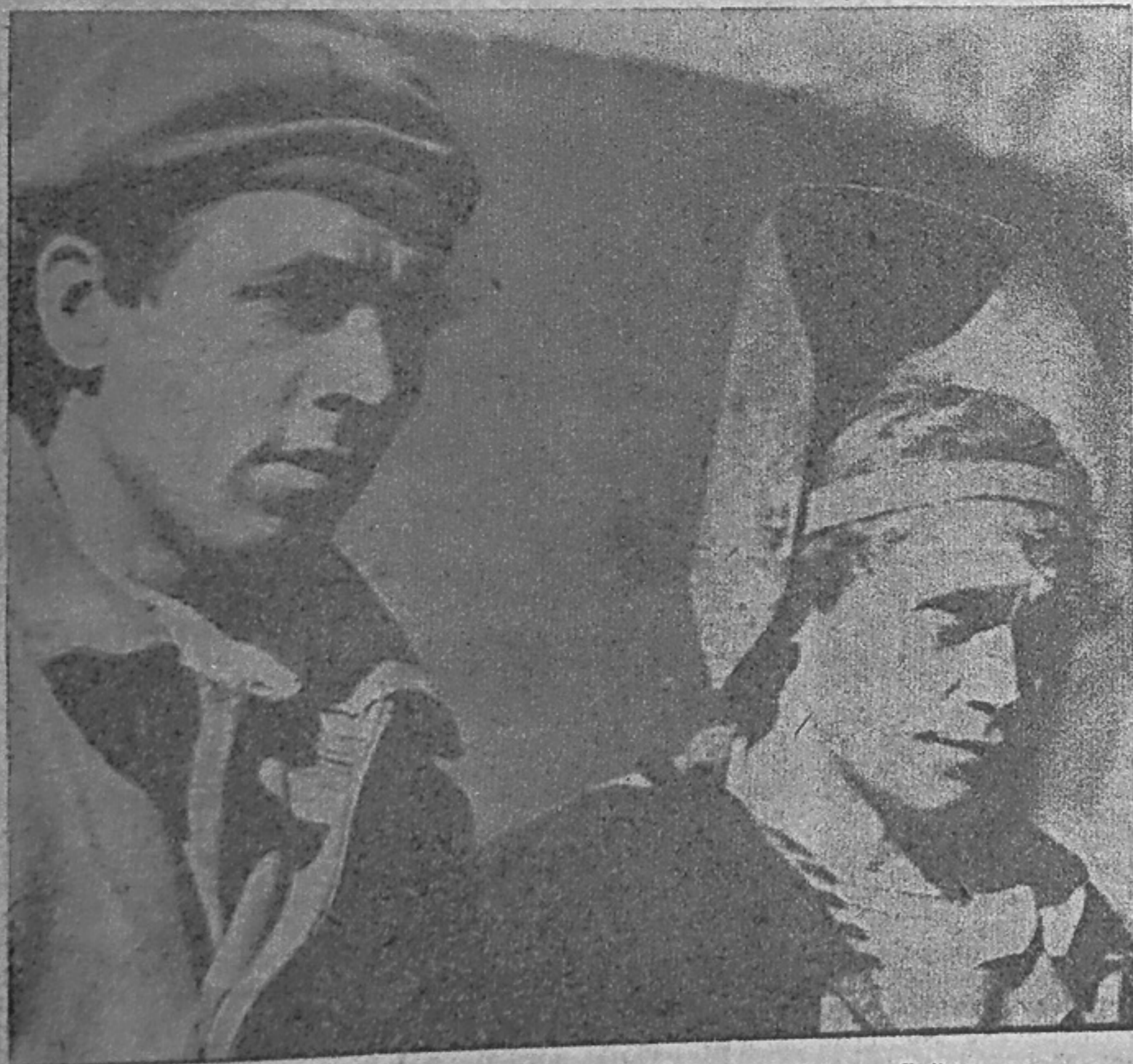
Бригада Н. Потерайло одна из передовых в Гидромонтаже. Сейчас она занята на сборке звеньев напорного водовода для третьего и четвертого агрегатов. НА СНИМКЕ (слева направо): передовые слесари-монтажники Максим Файзуллин и Иван Калинович. Фото А. БЕНЕДЮКА.
