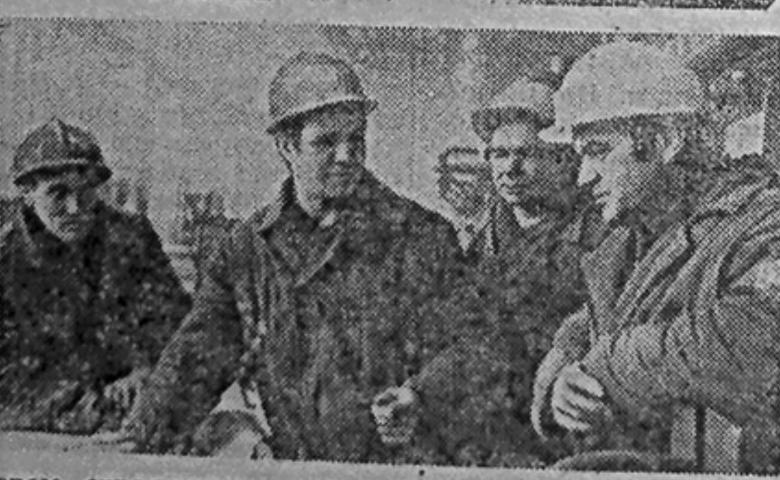
Новом строящемся цехе холодной прокатки нержавеющей ленты на Московском металлургическом заводе «Серп и молот». Партгрупорг участка, передовой строитель бригады коммунистического труда Московского механомонтажного управления треста «Металлургомонтажпрокат» В. Н. Константинов (второй слева), коммунисты участка электросварщики В. И. Ваулин (слева), Ф. Е. Кулешов (второй справа) и бригадир слесарей-монтажников Ж. А. Лемешко (Фотохроника ТАСС)
