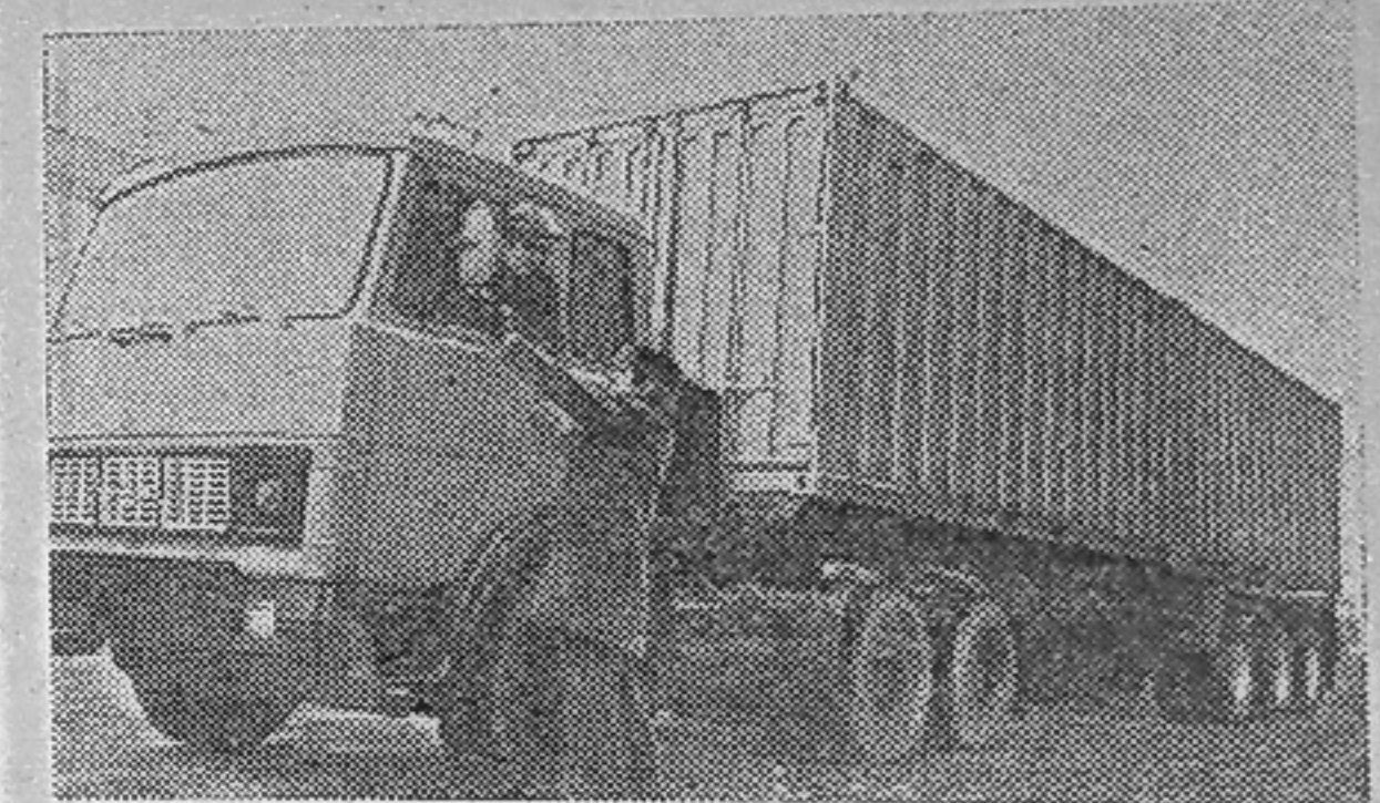
На Минском автомобильном заводе осваиваются новые образцы перспективной техники — автомобили и автопоезд семейства «МАЗ-6422». Среди них — автопоезд-контейнеровоз грузоподъемностью 32,5 тонны. На снимке: автопоезд для перевозки крупнотоннажных контейнеров. (Фотохроника ТАСС).
