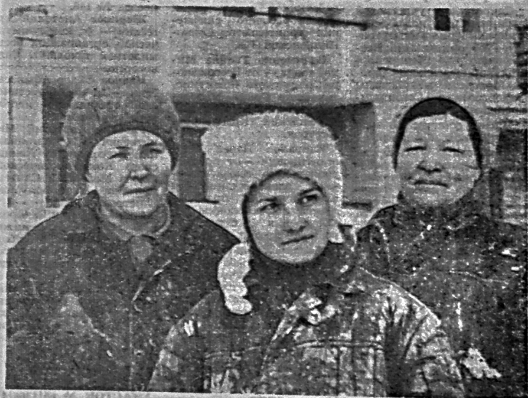
В строительстве города Саяногорска активное участие принимает СУ-69. На снимке: ударники коммунистического труда бригадир Н. П. Семиградская, штукатуры-маляры А. А. Ковригина и Н. С. Сергеева. Фото П. Дементьева.
