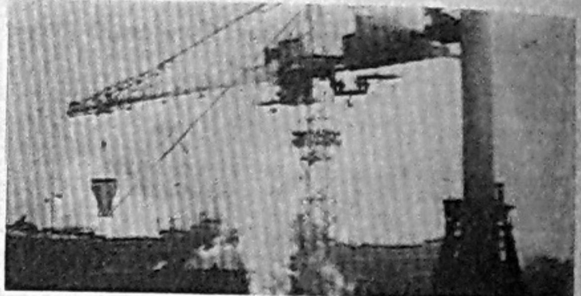
применение позволит подавать бетон в блок в два раза интенсивнее, чем кранами КБГС-450.
