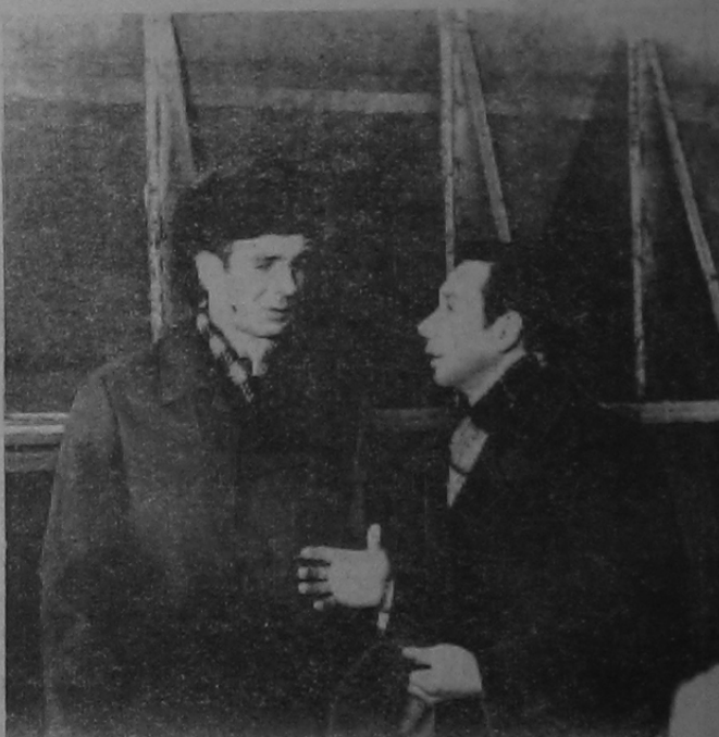
Заключение трудового договора между бригадами плотников-бетонщиков УОС-2 В. Познякова и слесарей-сборщиков объединения «Ленинградский Металлический завод» Героя Социалистического Труда В. Чичерова символизирует дружбу строителей Саяно-Шушенской ГЭС и коллективов предприятий Ленинграда.
