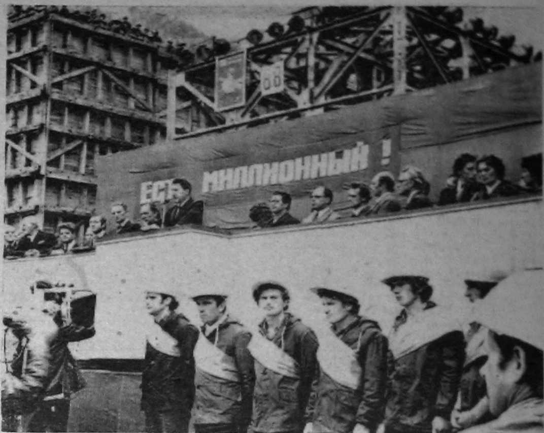
31 августа 1976 года. Левобережный котлован Саяно-Шушенской ГЭС. На торжественном митинге, посвященном укладке миллионного кубометра бетона.
