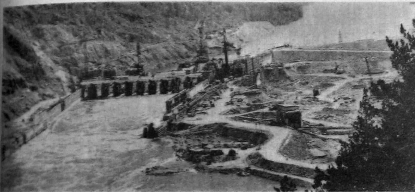
Карловский створ. Панорама строительства гигантской Саяно-Шушенской ГЭС. Фото П. ДЕМЕНТЬЕВА.
