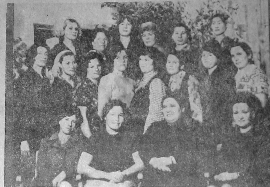
При учкомбинате на месячных курсах занимались бригады-отделочники со всех подразделений Красноярскгэсстрой. Все 15 человек хорошо сдали экзамены. На снимке: группа бригадиров-отделочников. Фото Г. КАНУНИКОВА.
