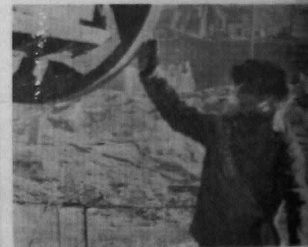
19 января 1976 года был уложен первый бетон в левобережном котловане.
