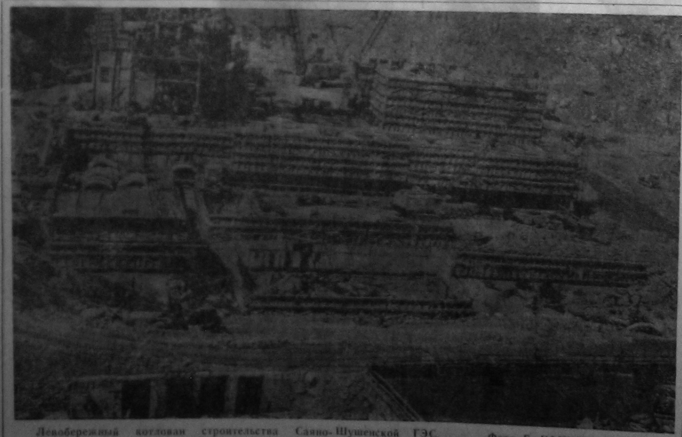
Левобережный котлоан строительства Саяно-Шушенской ГЭС.
