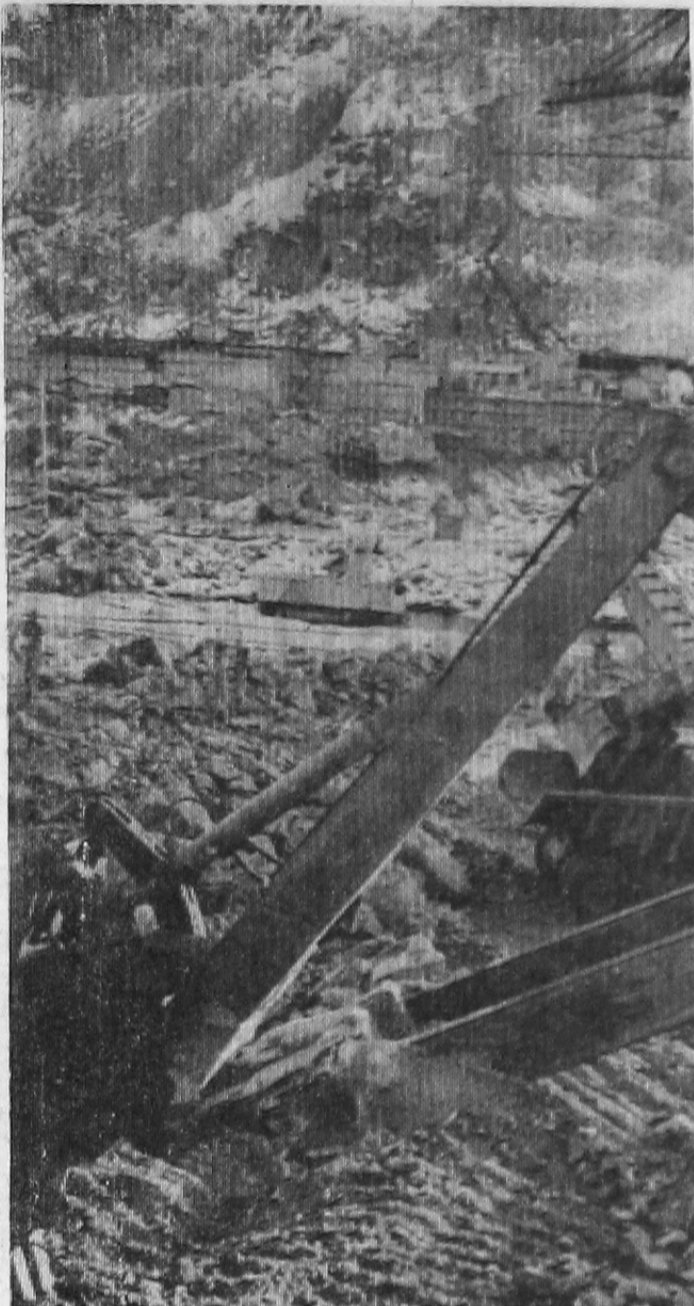
КОТЛОВАН ВТОРОЙ ОЧЕРЕДИ СТРОИТЕЛЬСТВА САЯНО-ШУШЕНСКОЙ ГЭС — ОДИН ИЗ ГЛАВНЫХ ОБЪЕКТОВ. ЗДЕСЬ ОСНОВНУЮ РАБОТУ ПО ЗАЧИСТКЕ СКАЛЬНОГО ОСНОВАНИЯ ВЫПОЛНЯЮТ ЭКСКАВАТОРЫ С ОБРАТНОЙ ЛОПАТОЙ.
